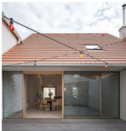
Zároveň s odstránením plastových okien upravili architekti aj rozmiestnenie a tvar otvorov. „Nové výplne sme zámerne poňali minimalisticky, aby kontrastovali s pôvodnými, tradične delenými oknami,“ vysvetľujú.
