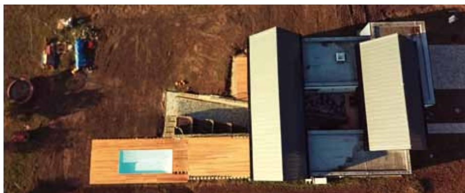
Sedlové střechy mají lehkou plechovou krytinu s čistými liniemi
